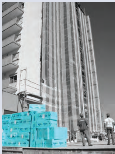
Reabilitação de fachada com FIBRANxps
