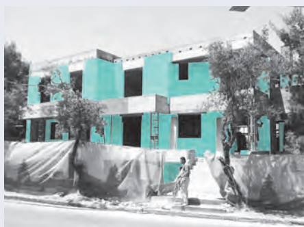
Reabilitação das fachadas de um edifício com isolamento térmico FIBRANxps ETICS
