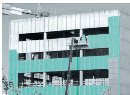
Edifício com fachada ventilada
