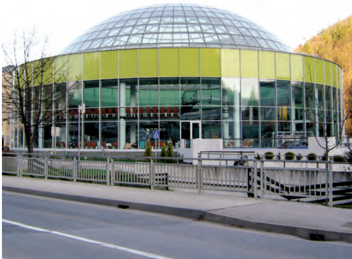
Isolamento interior de um edifício de uma piscina com FIBRANxps ETICS
