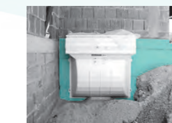
Muros de fundação isolados com FIBRANxps
