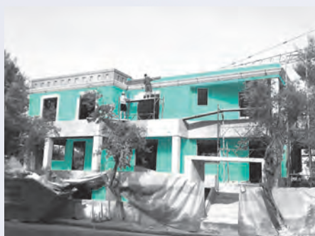
Reabilitação das fachadas de um edifício com isolamento térmico FIBRANxps ETICS
