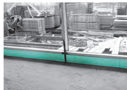
Isolamento térmico perimetral
