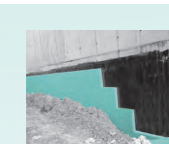
Muros de fundação isolados com FIBRANxps
