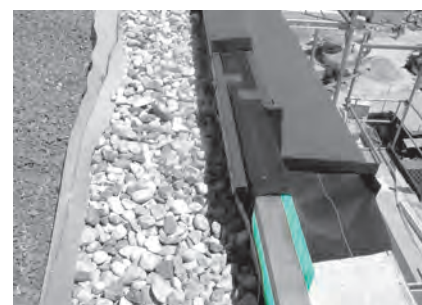
Pormenor de isolamento de um elemento enterrado
